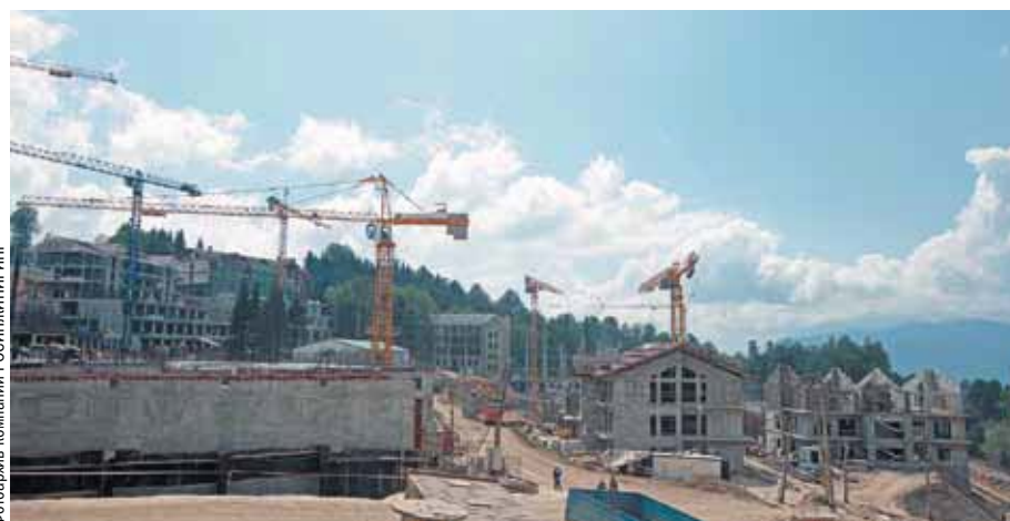
Ⓜ Площадка строительства горной олимпийской деревни (ГТЦ ОАО «Газпром»)
